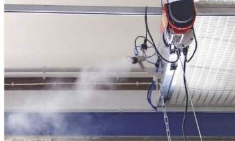
*! Im Oberflächenbereich sorgt Luftbefeuchtung für ein definiertes Raumklima – und damit für eine gleichbleibend sehr hohe Qualität.*
